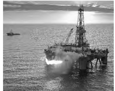
■ Gambar 3.6 Pengeboran lepas pantai rentan akan terjadinya kebocoran.
